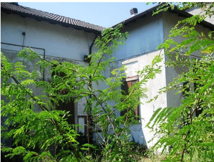
Foto 5) Immobili di Via Alfieri 1-3 vista nord - ovest area cortilizia
