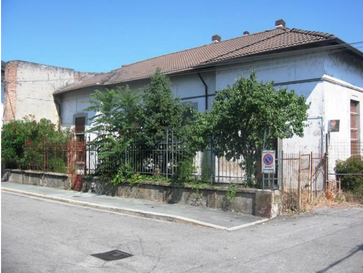
Foto 3) Immobili di Via Alfieri 1-3 vista sud -est
