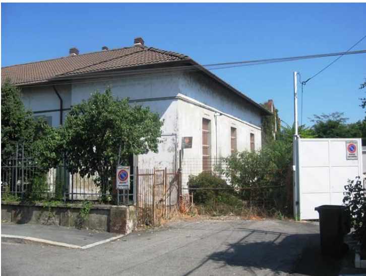
Foto 4) Immobili di Via Alfieri 1-3 vista sud -est ingresso area cortilizia
