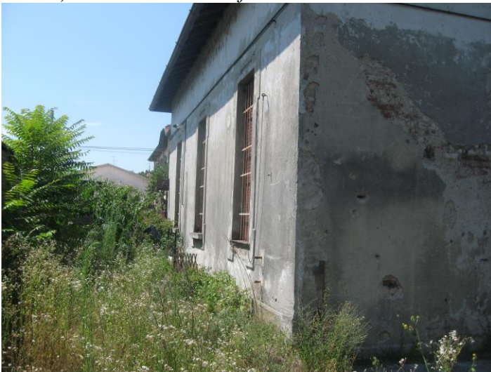
Foto 7) Immobili di Via Alfieri 1-3 civico 3 vista fronte sud da area cortilizia
