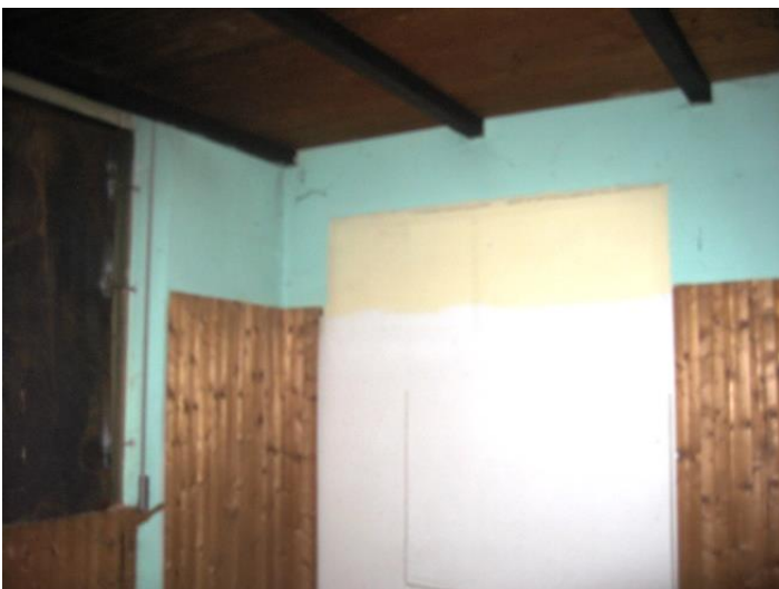
Foto23) Immobile di Via Alfieri 3 interno
