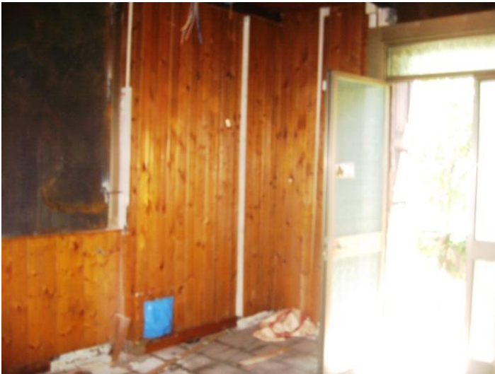
Foto19) Immobile di Via Alfieri 3 interno
