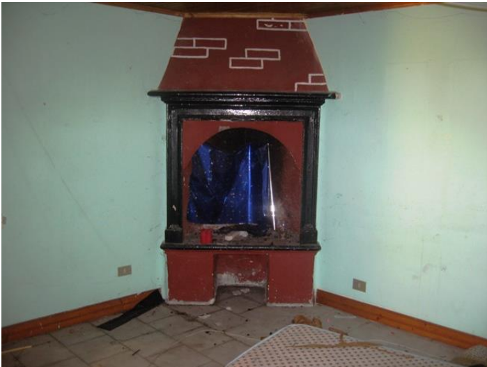
Foto22) Immobile di Via Alfieri 3 interno
