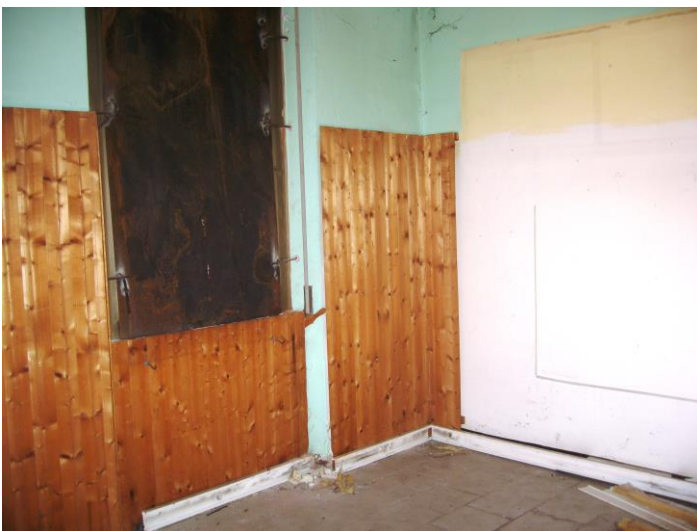
Foto 18) Immobile di Via Alfieri 3 interno
