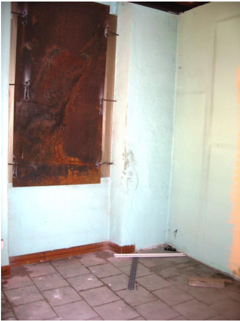
Foto21) Immobile di Via Alfieri 3 interno
