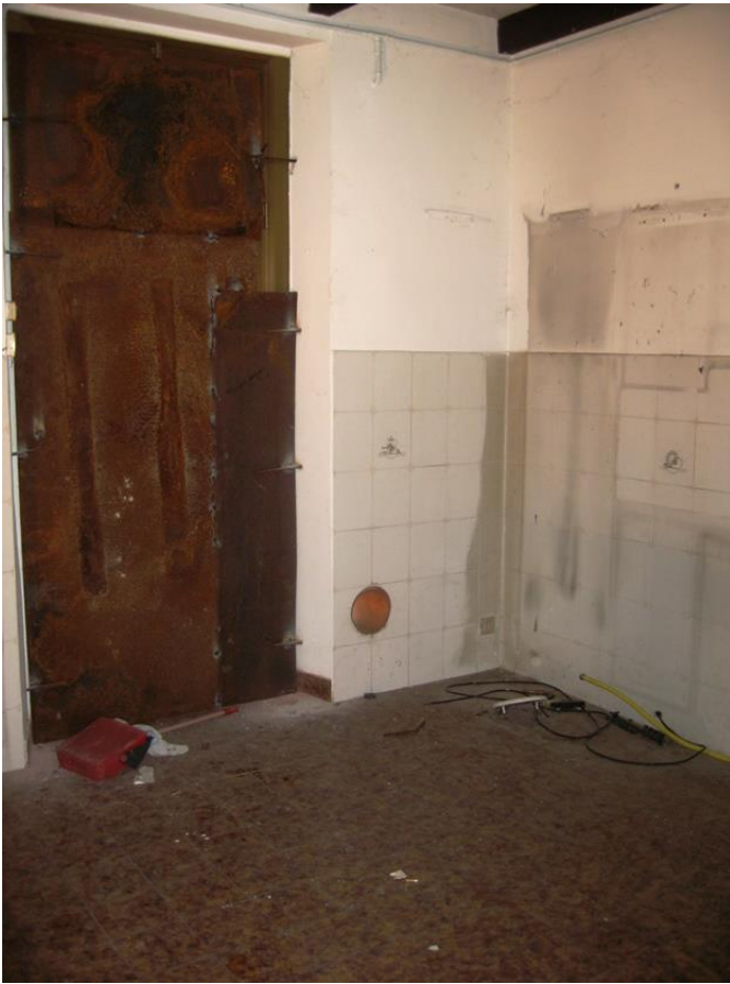
Foto 8) Immobile di Via Alfieri 1 interno
