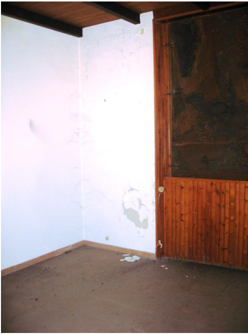
Foto10) Immobile di Via Alfieri 1 interno
