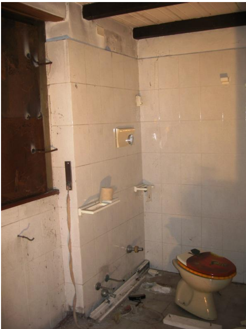
Foto20) Immobile di Via Alfieri 3 interno
