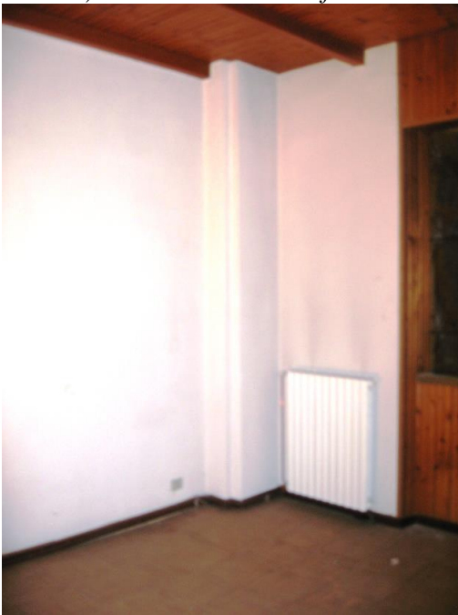
Foto11) Immobile di Via Alfieri 1 interno
